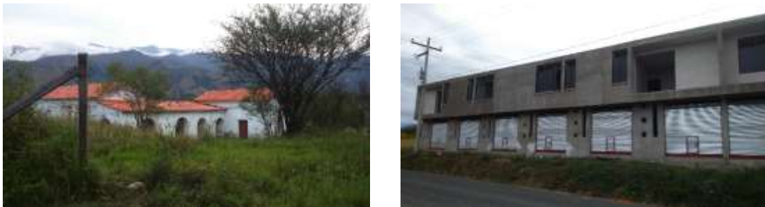
Figura 15: Antes y después de la vivienda en el medio rural
