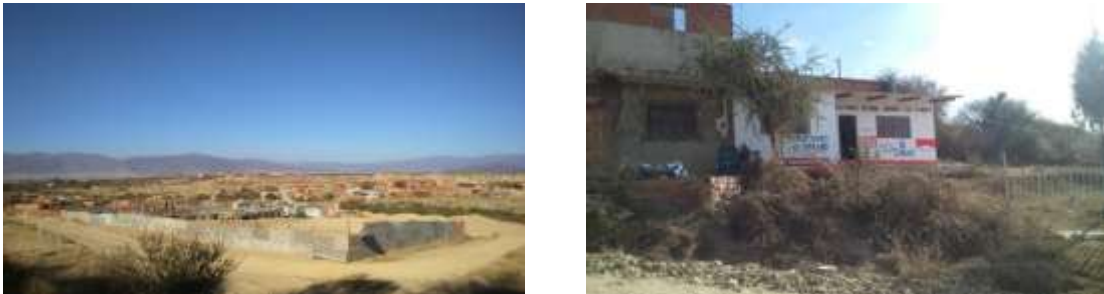
Figura 42: Equipamientos emplazados en el área de estudio
