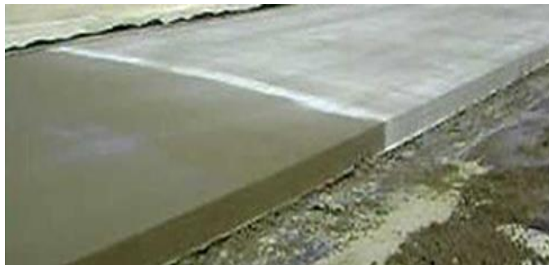
Figura 2.10 Juntas de construcción.
