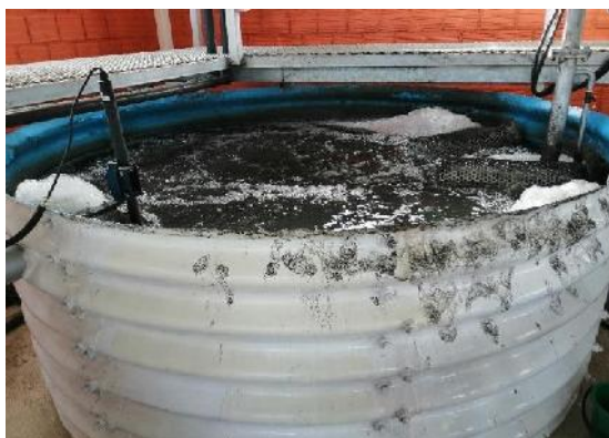
Figura 5. 15. Tanque aeróbico en funcionamiento con la inserción de lodo
