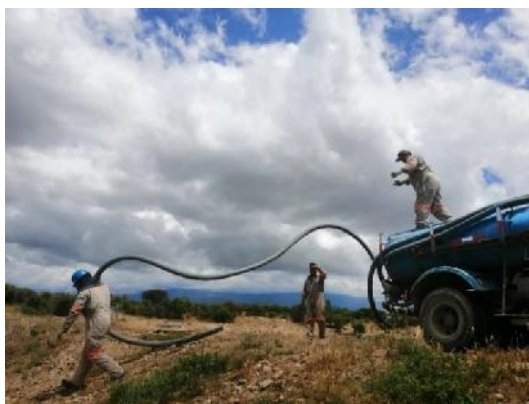
Figura 5. 1. Llevado de la manguera hacia el sitio para extraer el lodo
