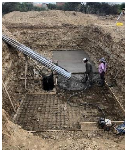
Figura 4. 4. Cimientos de concreto armado para la instalación de los tanques de acero galvanizado
