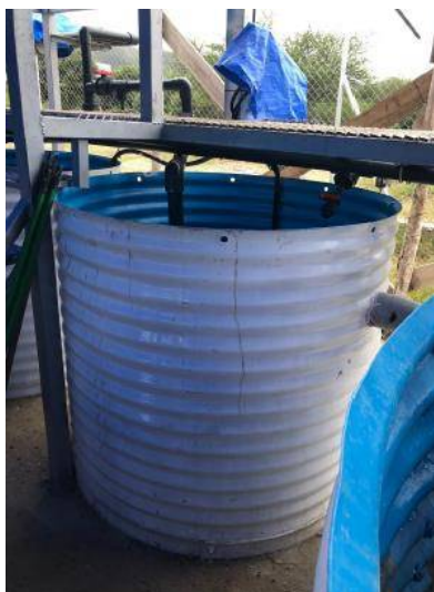
Figura 4. 36. Tanque Anaeróbico
