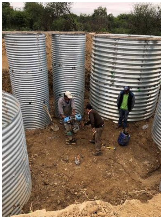
Figura 4. 16. Rellenado y compactado del terreno
