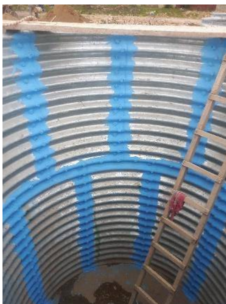
Figura 4. 15. Pintura impermeabilizante en las juntas del tanque
