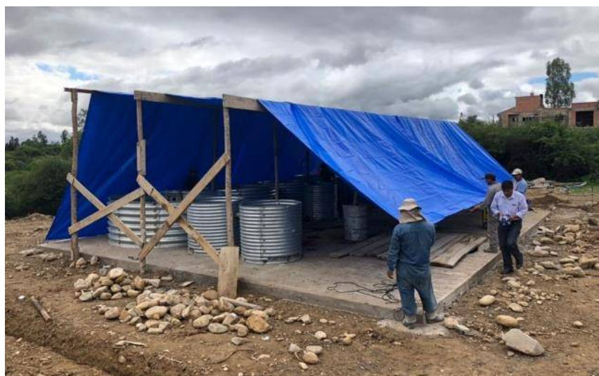
Figura 4. 19. Colocación de una carpa temporal para la protección de los equipos
