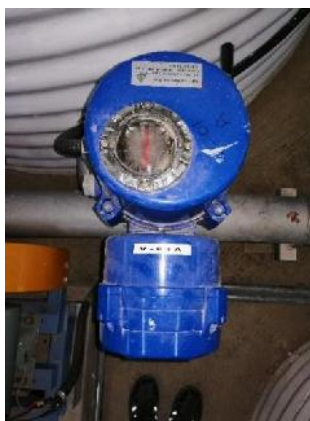
Figura 4. 50. Válvula de Retorno
