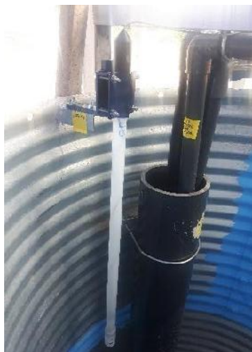
Figura 4. 52. Medidor de ORP (Potencial REDOX)
