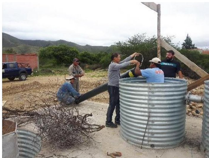
Figura 4. 20. Montado e interconexión de las diferentes tuberías en los tanques con los accesorios correspondientes
