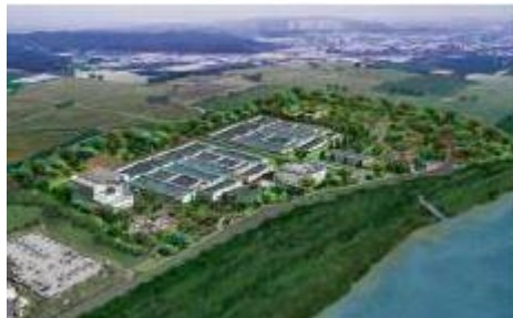
JinKun BNR WWTP (Fase I 80.000 m 3 / d, Fase II 120.000 m 3 / d), Ciudad de NamYangJoo, Provincia de Kyung Gee, Corea (CSBR)
