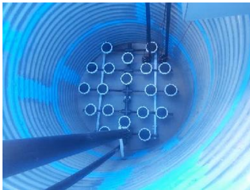
Figura 4. 46. Aireación del Tanque SBR
