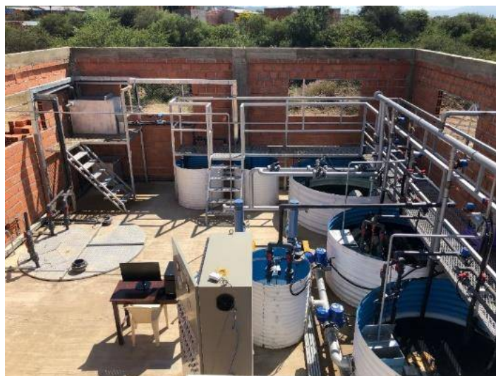
Figura 4. 29. Cerramiento del sitio con muro de ladrillo
