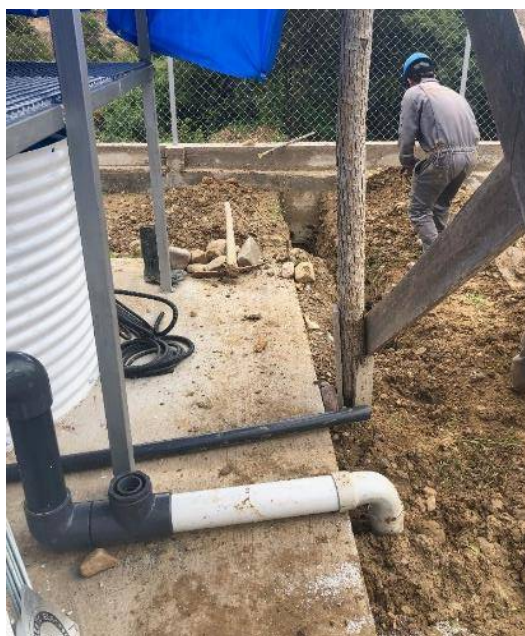
Figura 4. 25. Construcción de la línea de descarga del agua tratada
