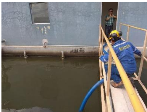
Figura 5. 12. Realizando la absorción de lodo
