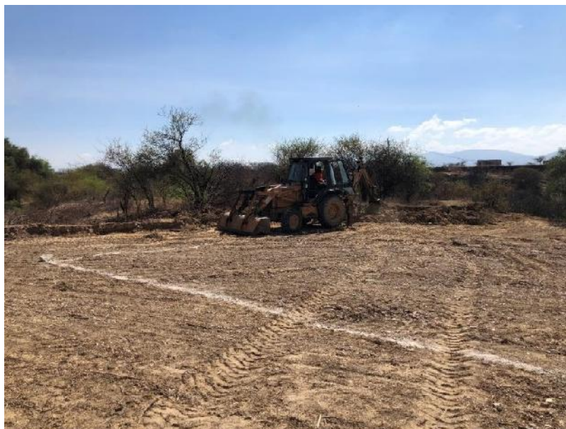
Figura 4. 1. Replanteo del lugar
