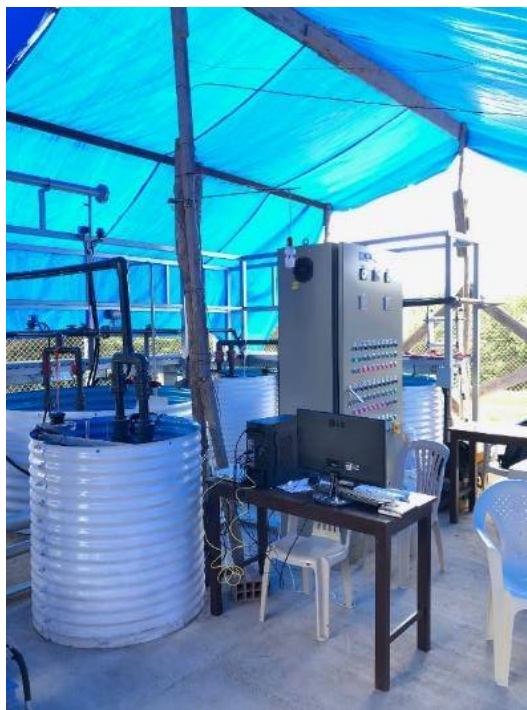
Figura 4. 28. Instalaciones eléctricas y puesta del panel de control
