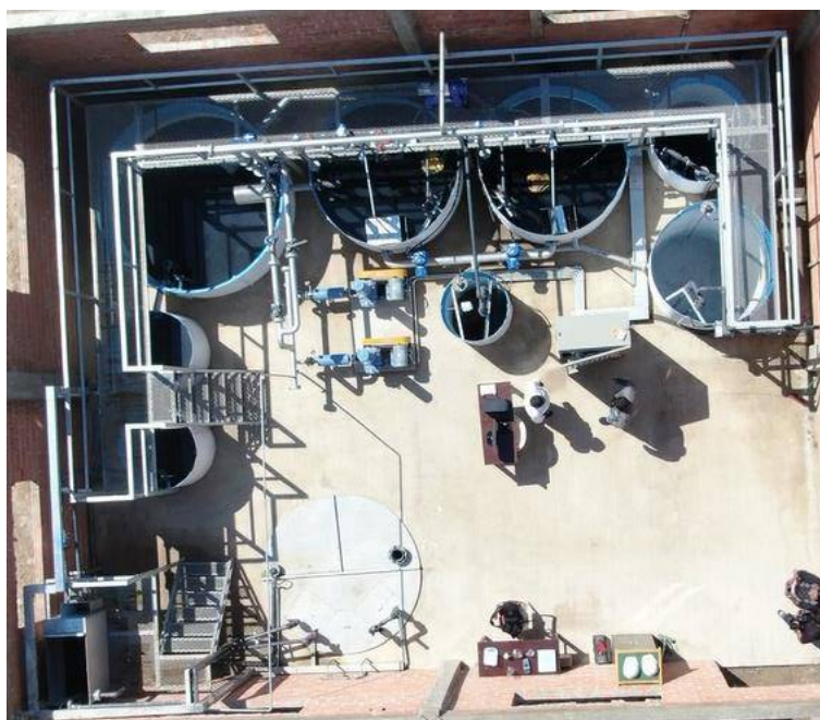
Figura 4. 33. Planta de demostración de tratamiento de aguas residuales, Barrio Catedral
