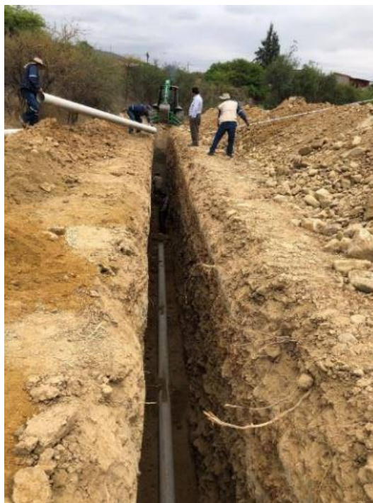
Figura 4. 10. Tendido de tubería de 8" desde la cámara existente hacia el tanque de ecualización pasando por una nueva cámara
