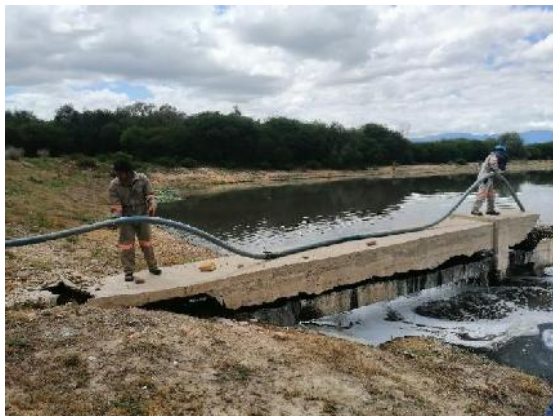
Figura 5. 2. Ubicación de la manguera para la extracción
