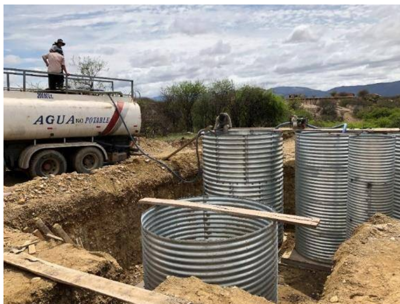
Figura 4. 13. Llenado de los tanques con agua no potable
