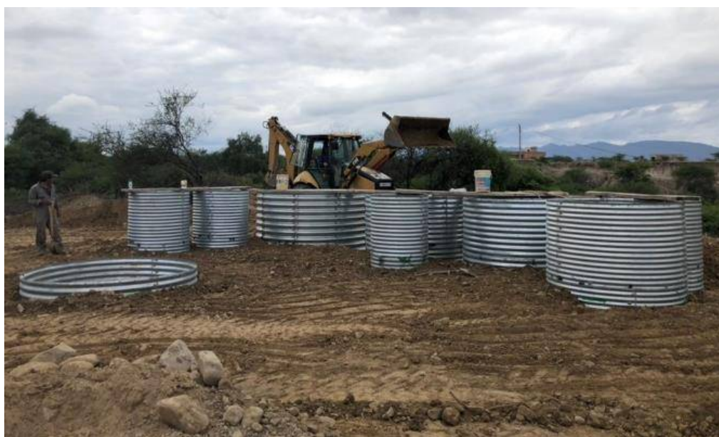
Figura 4. 17. Rellenado y compactado hasta el nivel del terreno original
