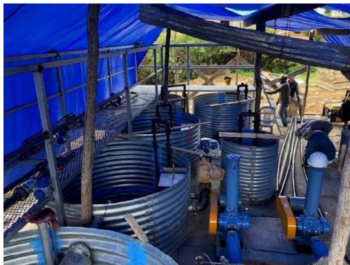
Figura 4. 26. Instalación de andamios, escaleras y pasamos
