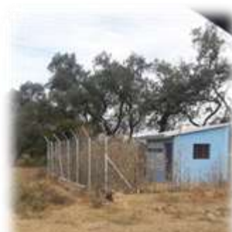
Caseta de bombeo para pileta común
