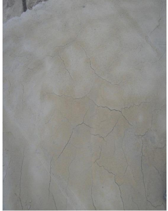
b) Fisuras en losa alivianada con viguetas pretensadas
