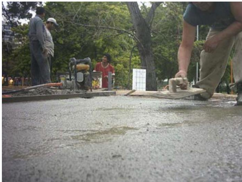
Figura 19 Fratasado de una losa de hormigón
