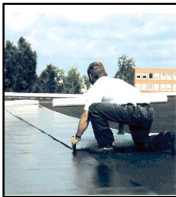
Fig. 2.17 Manta asfáltica Sika en el proceso de imprimación.
