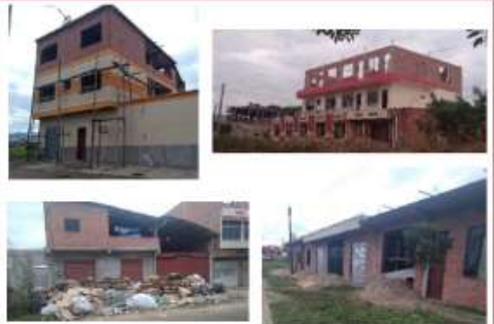
Ilustración 02 Imágenes de viviendas de terreno N° 2. Elaboración propia
