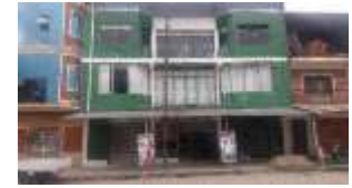
Ilustración 3 Instituto técnico Sercosur Fuente imagen propia
