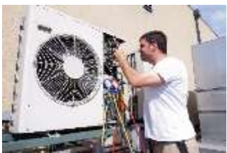
Ilustración 16 Taller de refrigeración y climatización
