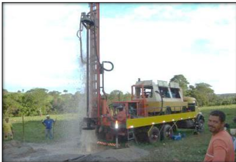
Figura 3.8 Maquinaria de perforación de pozos de agua
