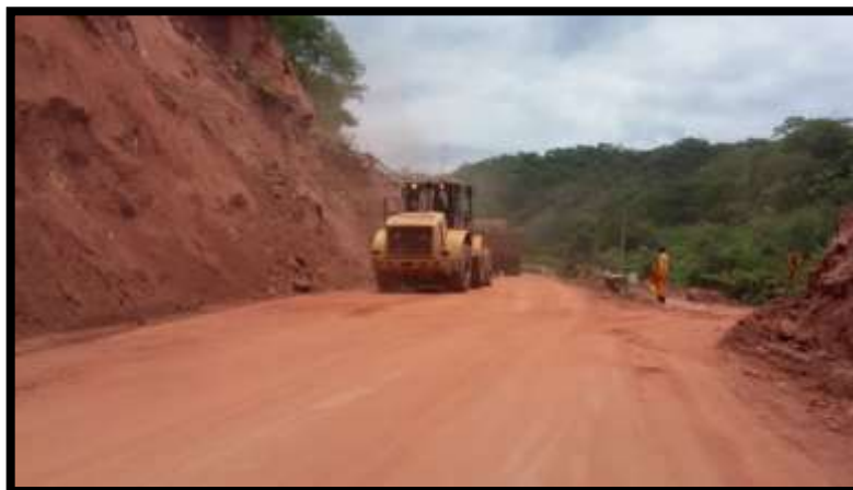
Figura N° 2.7 Compactación de capa sub – base
