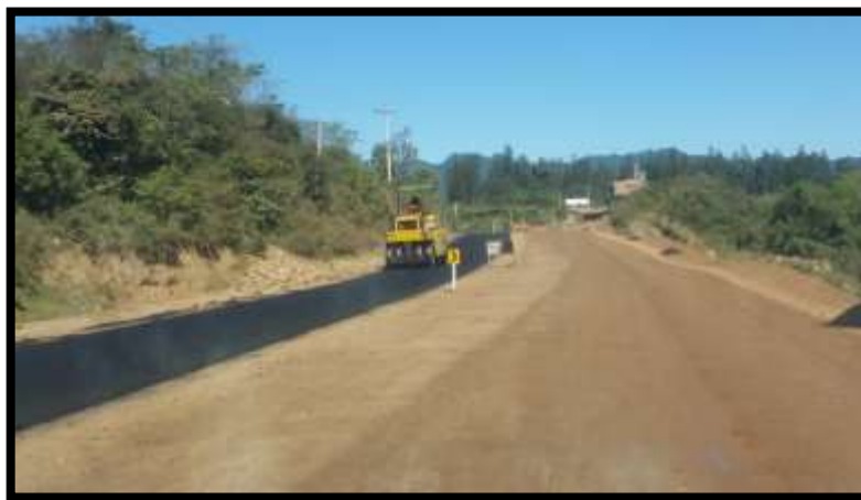
Figura N° 2.8 Capa de rodadura
