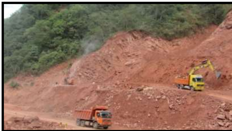
Figura N° 2.2 Movimiento de tierras
