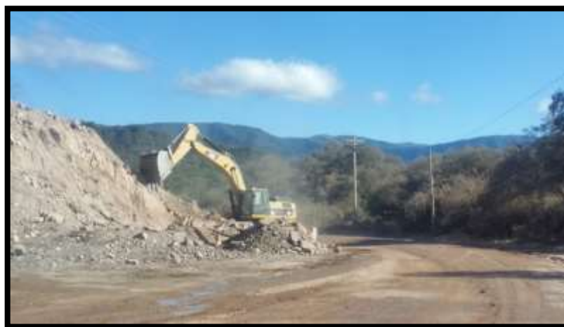
Figura N° 2.3 Excavación para perfilado de taludes
