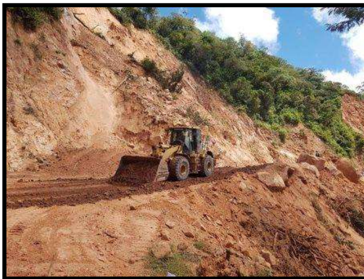
Figura N° 2.5 Relleno para construcción de terraplén
