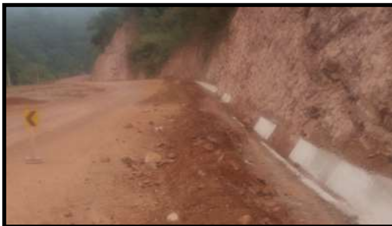
Figura N° 2.6 Construcción de drenaje superficial
