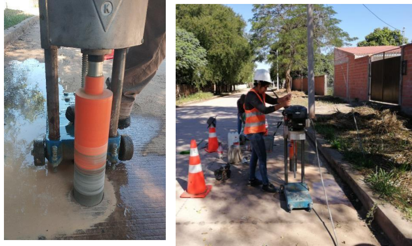
Imagen 4-15 Extracción de los testigos de las calles La Paz y Potosí
