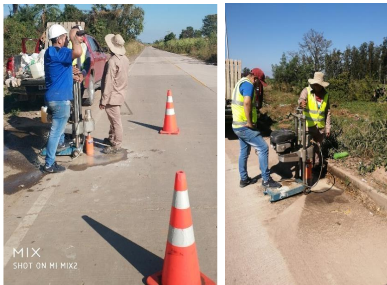
Imagen 4-16 Extracción de núcleos del tramo Campo Pajoso-Caraparí
