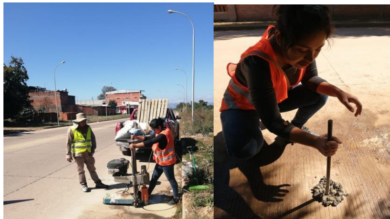
Imagen 4-13 Sellado y tapado de extracción de testigo en Bermejo
