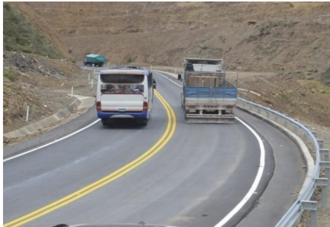
Imagen 3-1 Tramo Puente Jarcas- Piedra Larga
