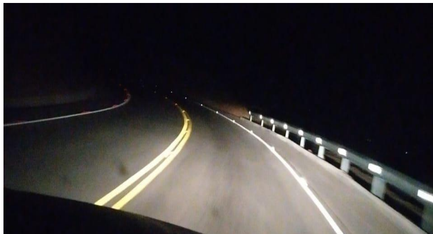
Imagen 4-8 Vista del tramo Puente Jarcas-Piedra Larga
