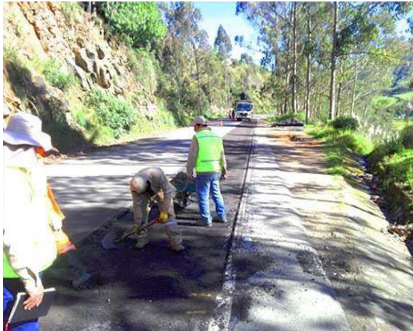
Imagen 2-6 Colocación de parche en el tramo Bermejo
