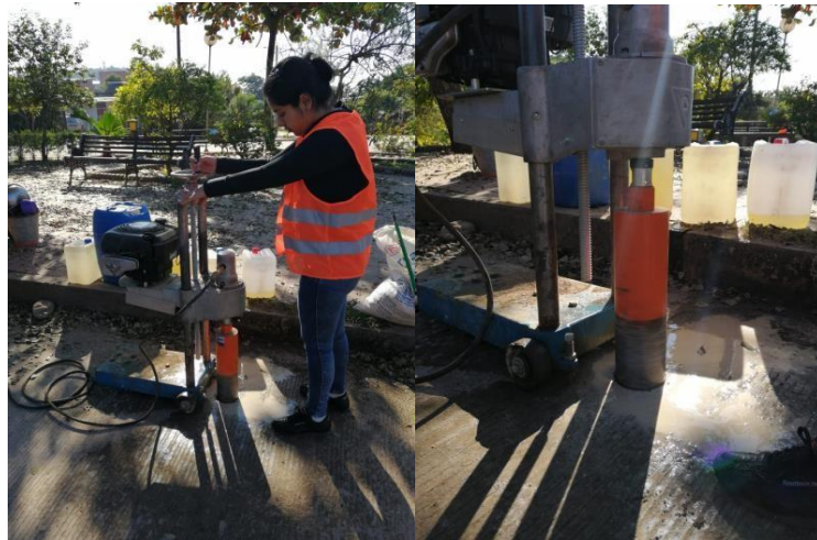
Imagen 4-12 Extracción de núcleos del tramo de urbano Bermejo
