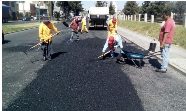
Imagen 2-2 Colocación de la mezcla asfáltica en plataforma
