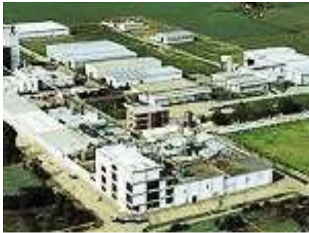
Ilustración 1 Planta Industrial https://definicion.de/plantas-industriales/
