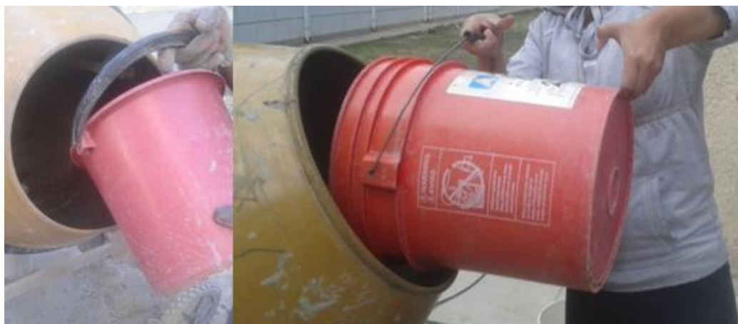
Figura 3.4 Dosificación de agua
