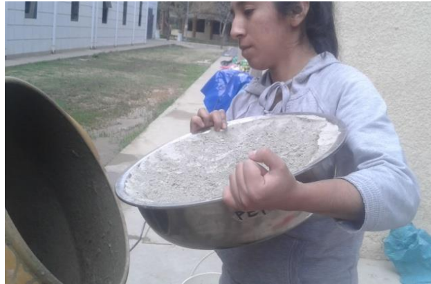
Figura 3.6 Dosificación de cemento
