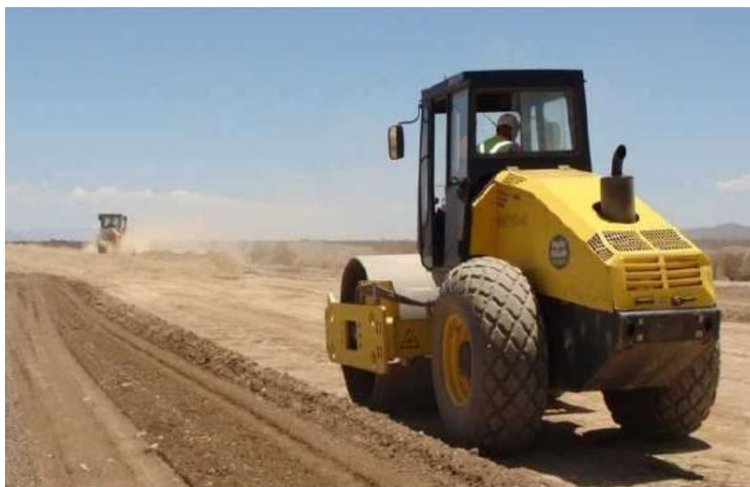
Figura 2.6.2 Estabilización por compactación mecánica
