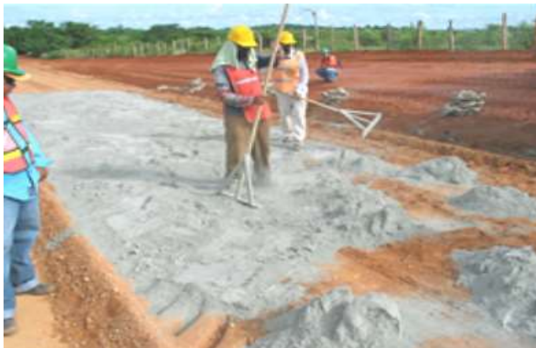
Figura 2.6.3 Estabilización con cemento
