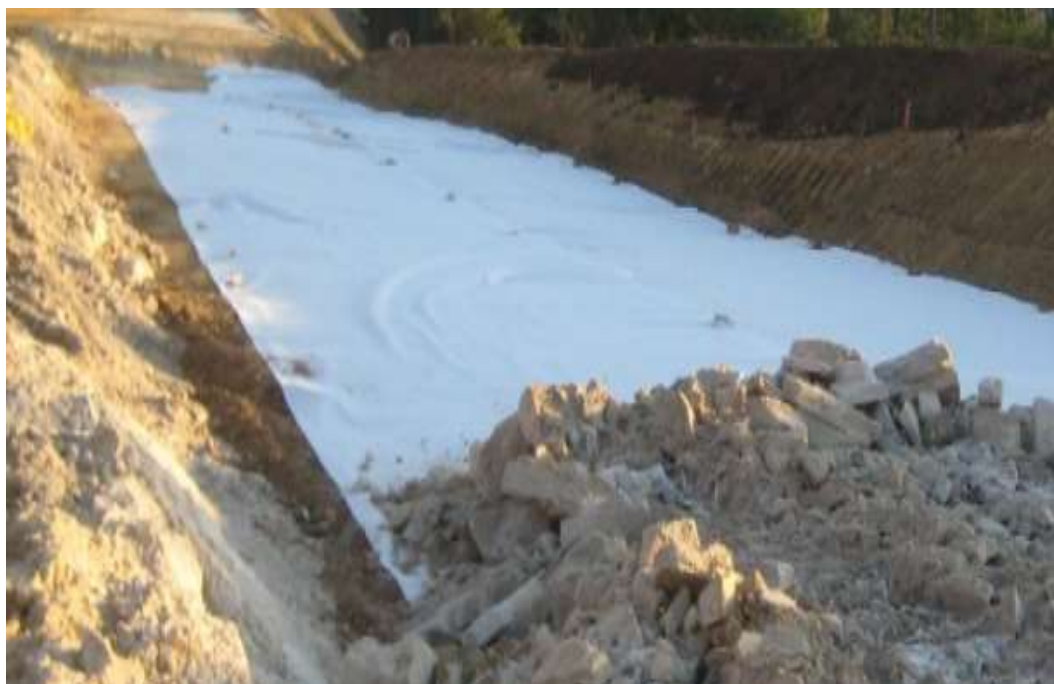
Figura 2.6.1 Estabilización con geotextiles
