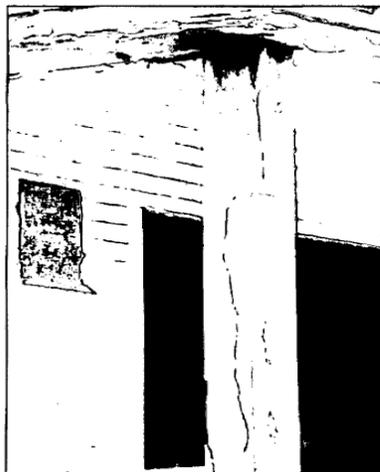
Figura 19. Fisuras características de una columna
