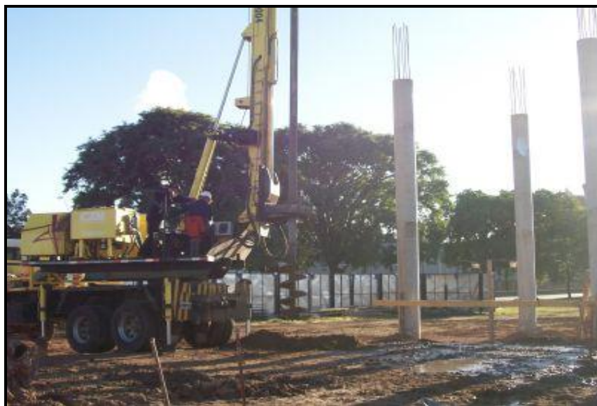
Fotografía 5.1 Construcción de un grupo de pilotes perforados
