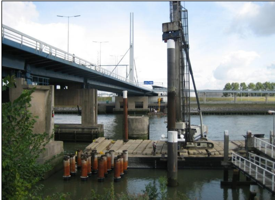
Fotografía 4.1 Hincado de pilotes de tubo de acero
