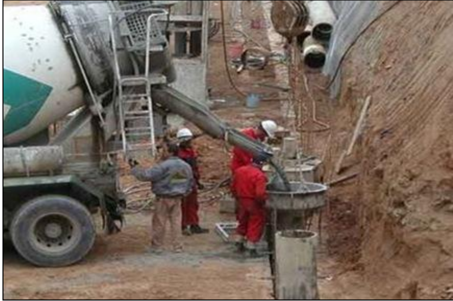
Fotografía 5.4 Vaciado de concreto, con una resistencia medida en cono de Abrams de 10 a 15cm (pilote construido “in situ”)
