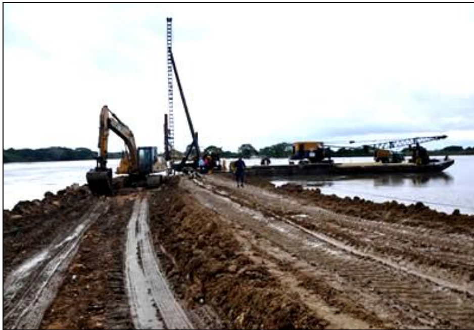
Fotografía 5.5 Pilotes de madera hincados por martinete
