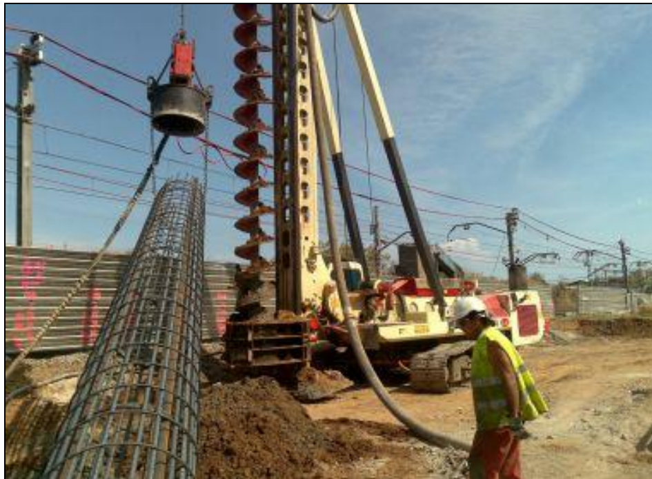
Fotografía 5.3 Pilote construido “in situ” (Una vez perforado el hoyo, se coloca el armazón del pilote)
