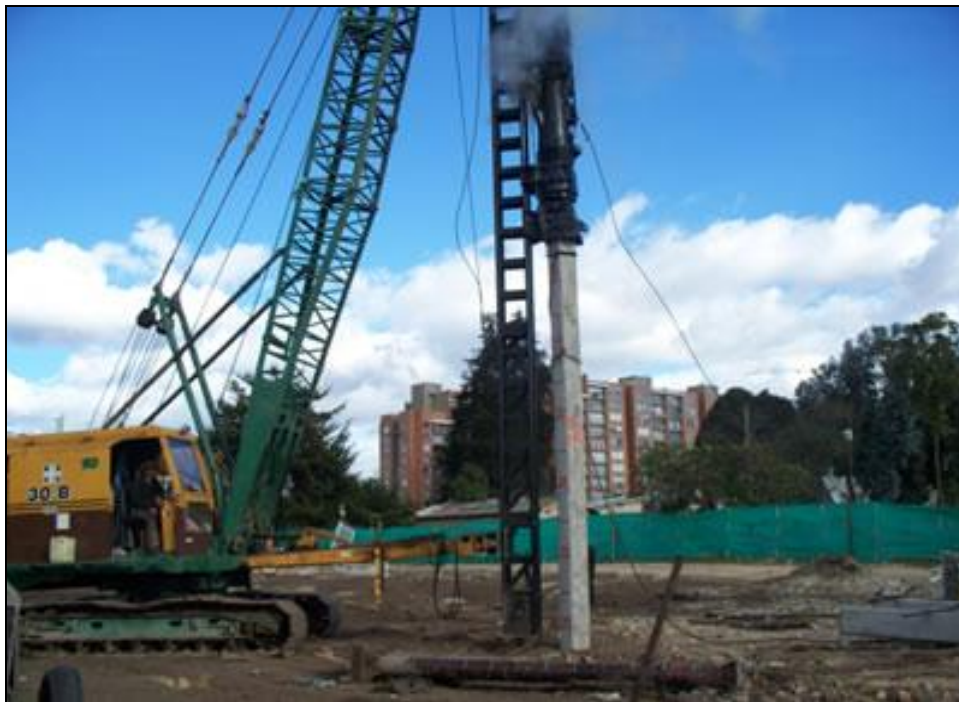
Fotografía 4.2 Hincado de un pilote prefabricado
