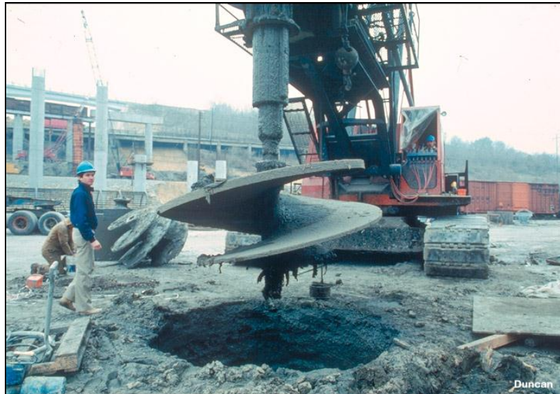
Fotografía 7.1 Perforación de un pilote
