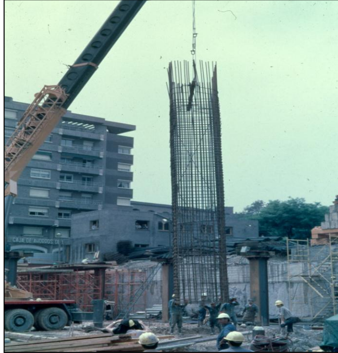
Fotografía 7.2 Colocado de la armadura para la construcción de un Pilote hincado “ in situ”
