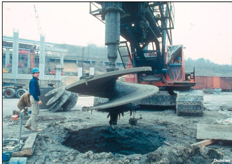
Fotografía 7.1 Perforación de un pilote
