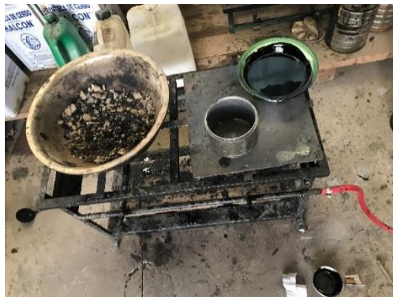
Figura 3.29. Agregado más cemento asfáltico para realizar la mezcla
