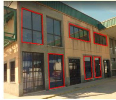
Características del espacio Fuente: Google (Elaboración propia)
