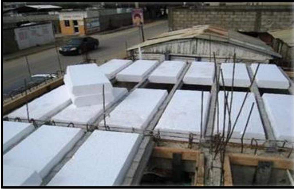
Figura N°4.4. “losa alivianada viguetas pretensadas”
