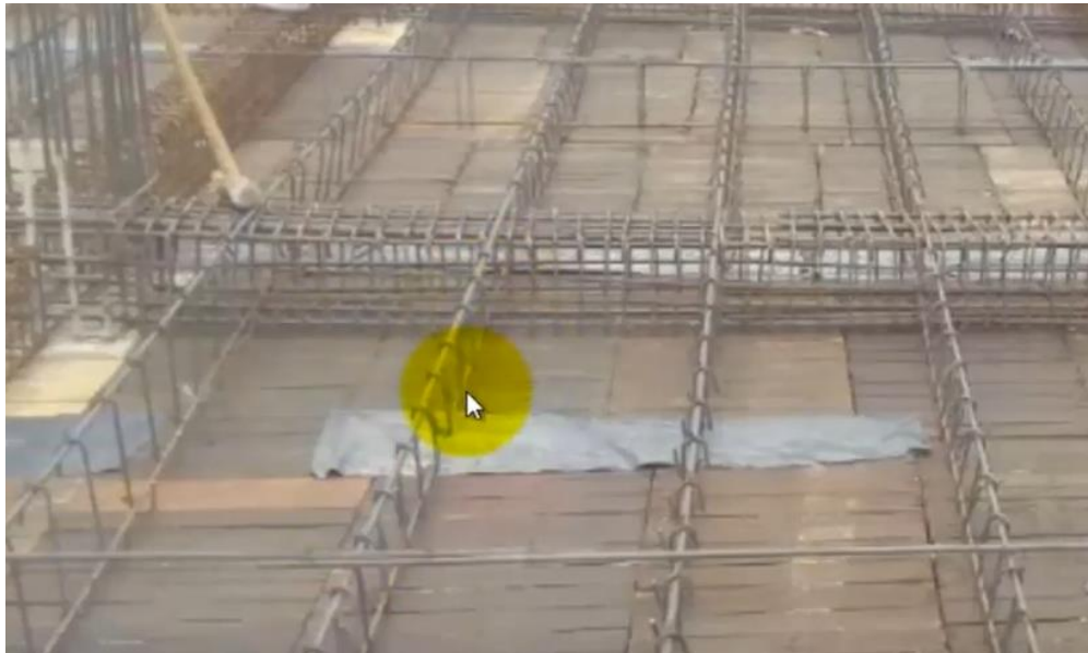
Figura N°4.1. Losa “Nervada unidireccional”
