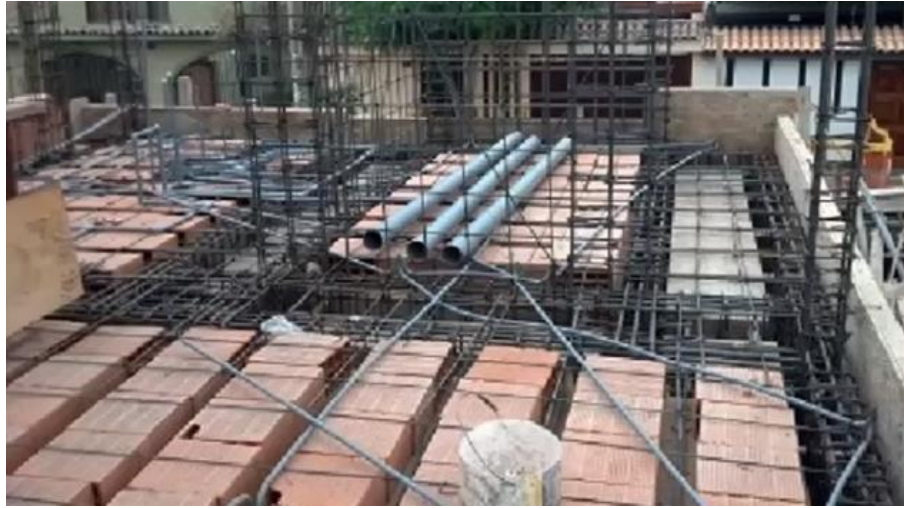
Figura N°4.2. Losa “Nervada armado del casetón removible”
