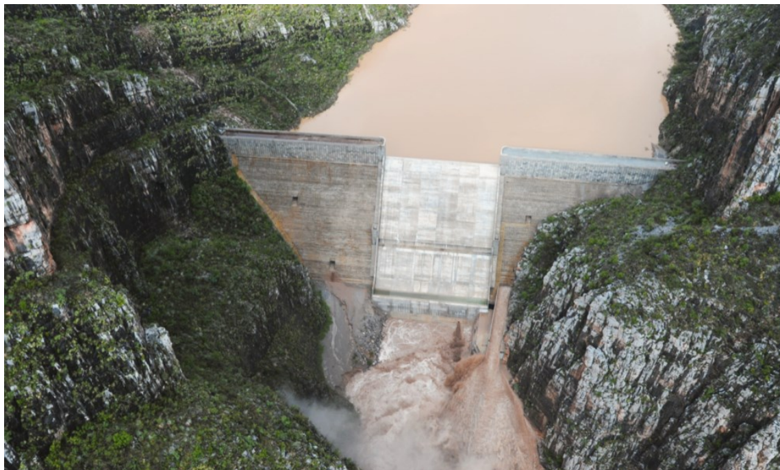
Figura 2.2 – Presa Rompe picos, Santa Catarina, México.
