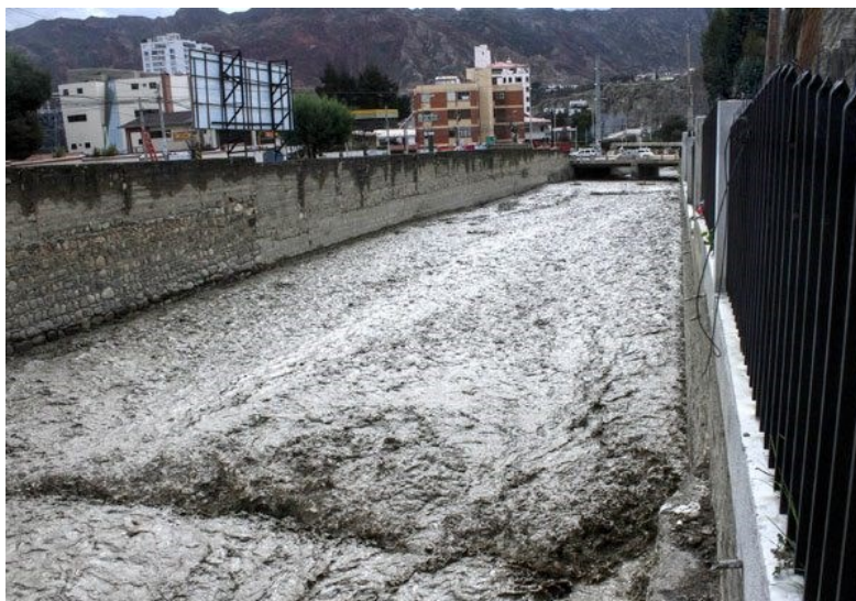
Figura 2.3 - Canalización de cursos de agua en La Paz, Bolivia.
