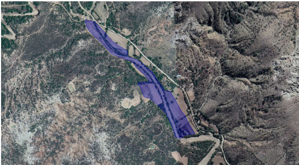
Figura 4.12 – Vista satelital área de inundación, T = 25 años.
