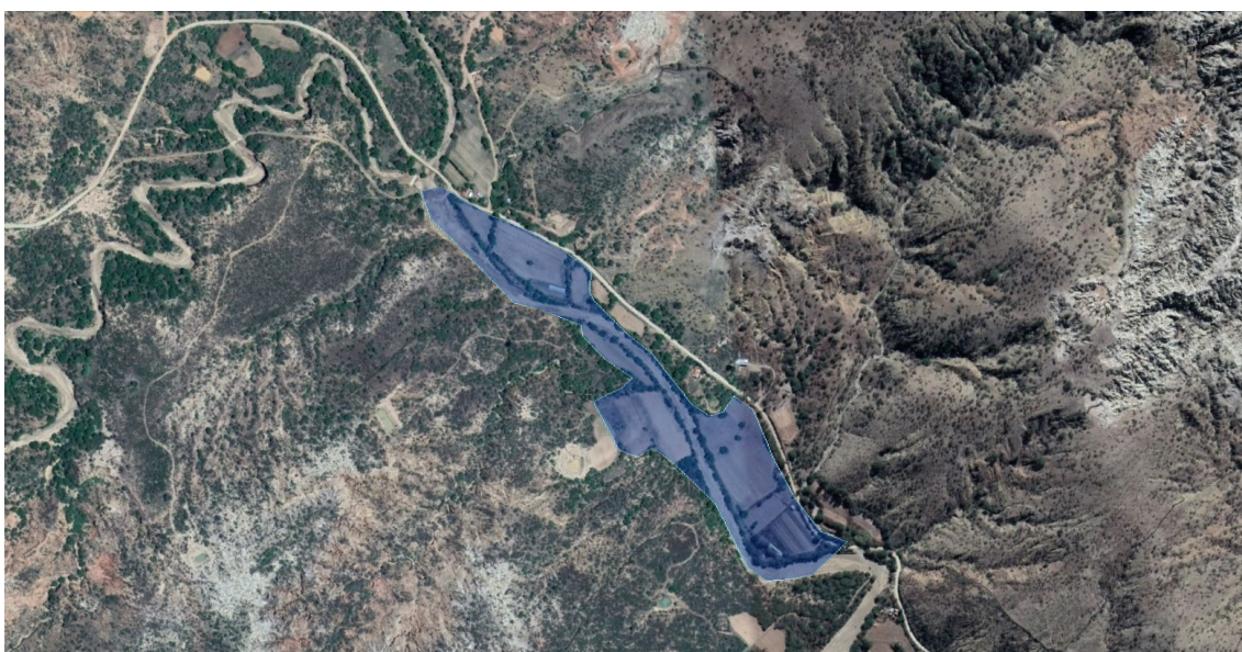
Figura 4.14 – Vista satelital área de inundación, T = 500 años.
