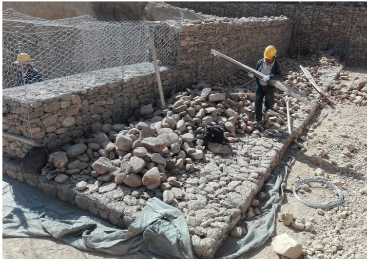
Figura 2.20 – Geosintéticos en base de colchonetas.
