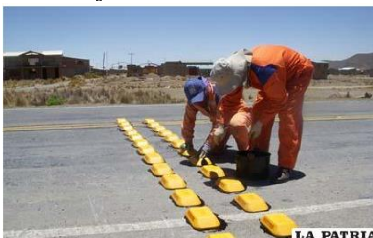
Figura 2.11 Colocación de tachas
