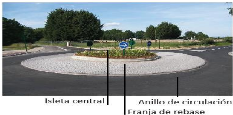
Figura 2.14 Aspecto físico de una rotonda.
