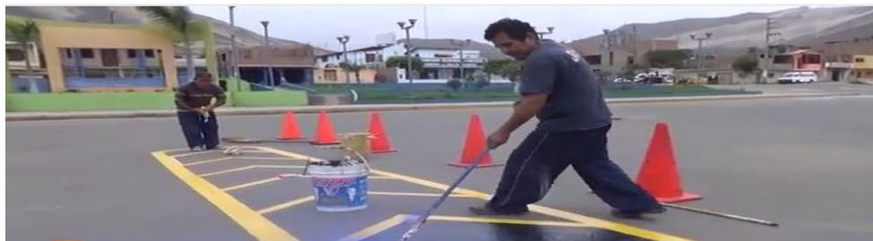
Figura 2.19 Mantenimiento y conservación de señalización horizontal.
