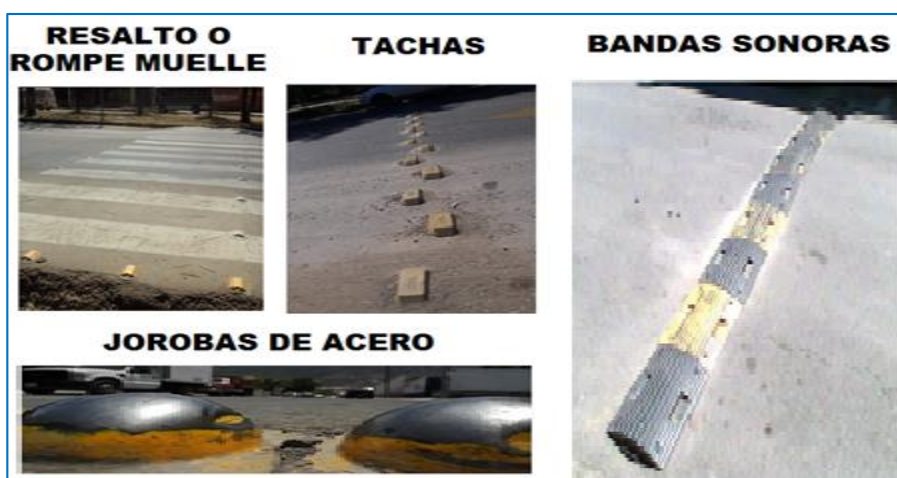
Figura 2.8 Elementos de seguridad vial reductores de velocidad.
