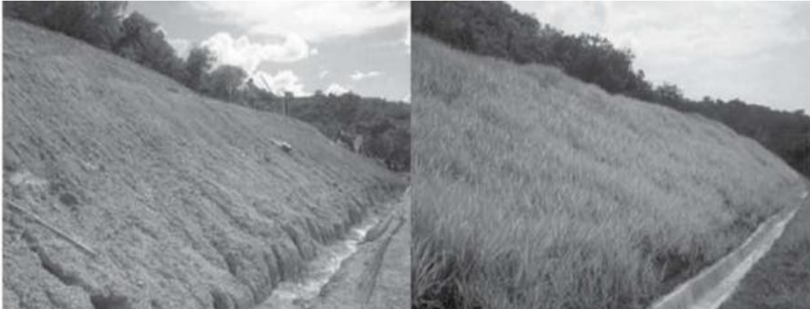
Figura 2.9 Mantos control erosivo (Antes- después).
