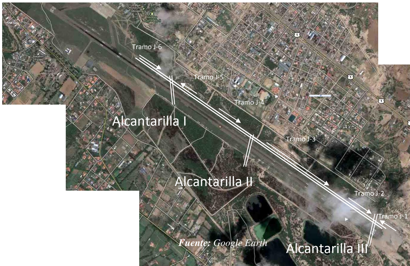
Figura 3.10 Canal J y sus tramos
