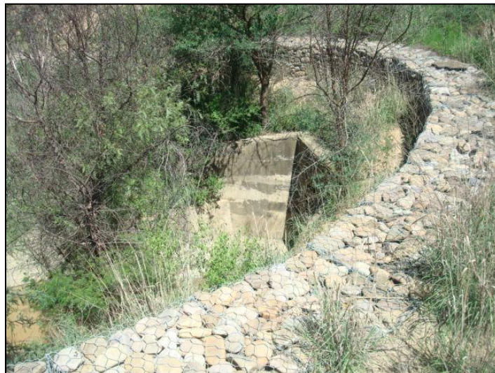
Figura 3.5 Gavión de protección salida quebrada SILS (Sector Sur)
