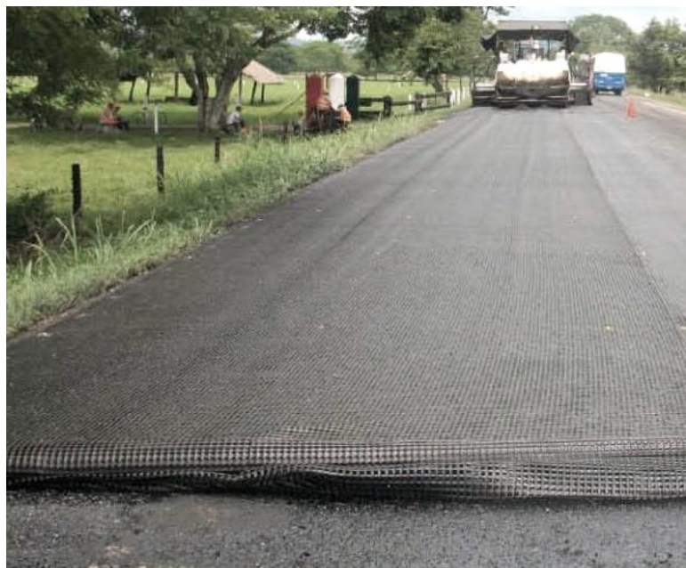
Figura 2.6 Proceso de colocado geomalla de fibra de vidrio
