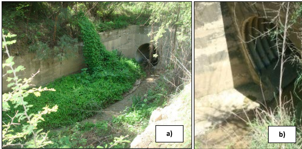
Figura3.4: (a) Canalización quebrada SILS (Sector Norte) (b) Canalización quebrada SILS (Sector Sur)
