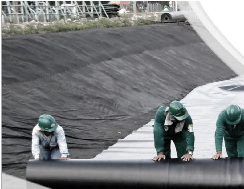
Figura 2.8 Colocado Geomembranas.
