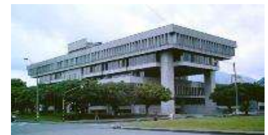
IMPOTENTE GERARQUIZACION DE LA ENTRADA AL EDIFICIO
