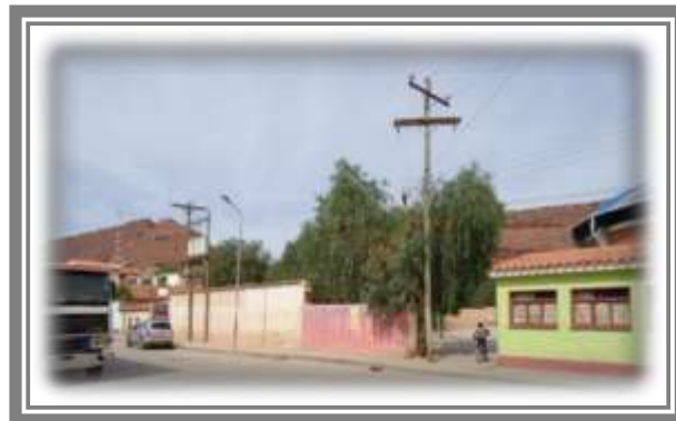
Figura 22. Tendido de luz eléctrica, transformador eléctrico.
