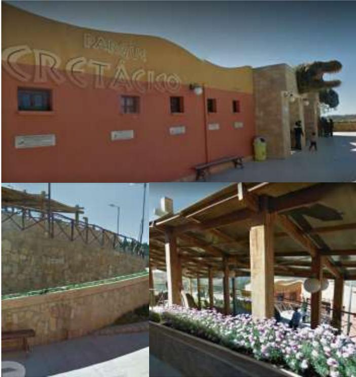
Este parque cuenta con distintos materiales como ser ladrillo, piedra, estructuras de madera ,cubierta de policarbonato e incluso con losa que esta revestida con detalles que simulan ser de tierra para estar coherente con la temática de la era cretácica.
