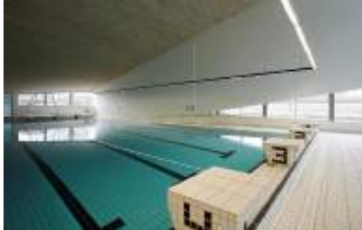
Figura 29 Vista interior Centro de Rehabilitación Vandhalla (Piscina)
