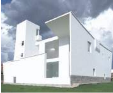
Figura 64: fachada, UASB Fuente: ARQA
