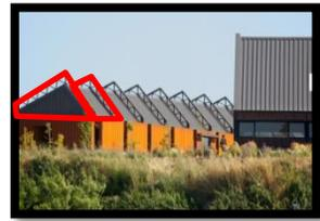
Todas las cubiertas son de zincalum. Asimismo, en todos los edificios la estructura (metálica y de hormigón) se propone a la vista como una manera formal de acentuar la rigurosidad y tecnología con la que se trabaja en el Centro.
