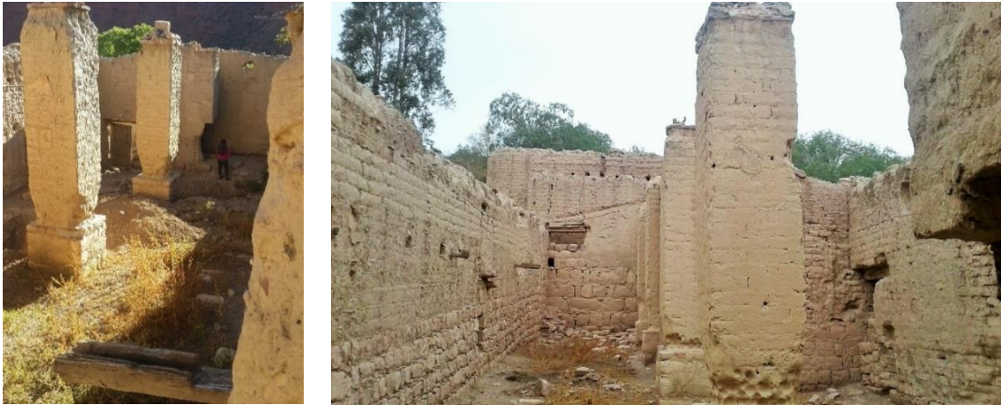
Figura N°30: Bodega de fermentación ruinas “La Dorada”
