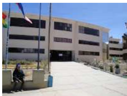
Utilización de vidrio en fachadas
