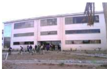
Bloque de aulas
