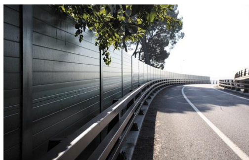
Figura N° 38 Pantallas acústicas ACH
