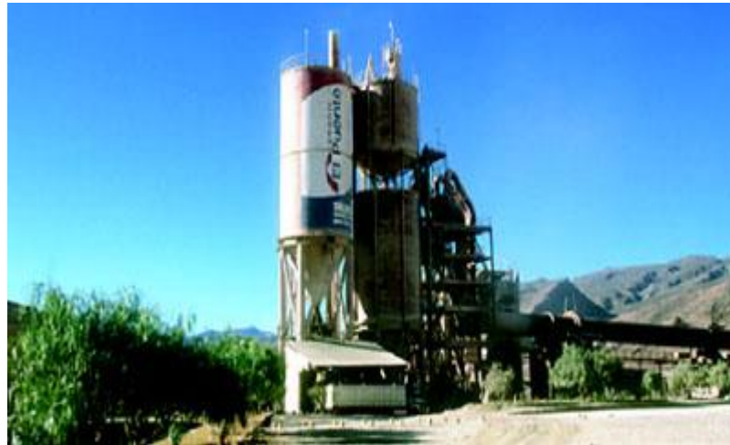
Fotografía 2.2 Fábrica de Cemento El Puente
