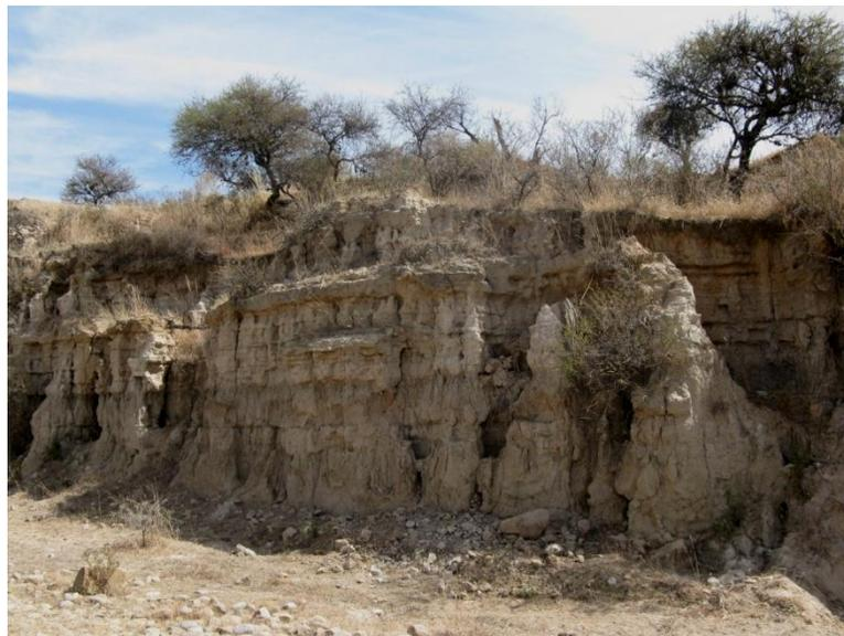
Foto 3.1 Presencia del fenómeno erosivo en los taludes del tramo en estudio
