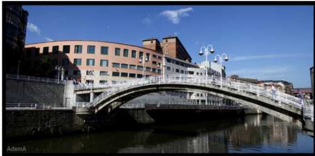
Fig.3.4 Paso peatonal de la Ribera, Ribera del Casco Viejo-Bilbao 20 m de luz, F:L= 1:7
