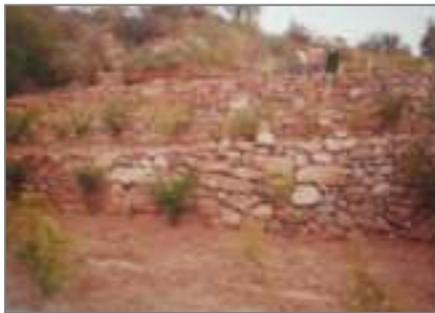
**2do pasó** se debe nivelar y compactar las terrazas con la palao rastrillo, de tal forma que las terrazas queden bien niveladas. Al finalizar tenemos una terraza nivelada, con taludes de una altura aproximada de un metro. La nivelación impide que el agua de lluvia o riego escurra hacia un lado u otro evitando la erosión en forma total.
