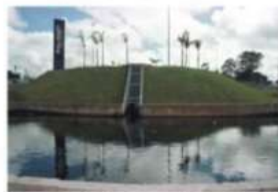
Reservatório de contenção de las águas de las lluvias - Forte IPPUC
