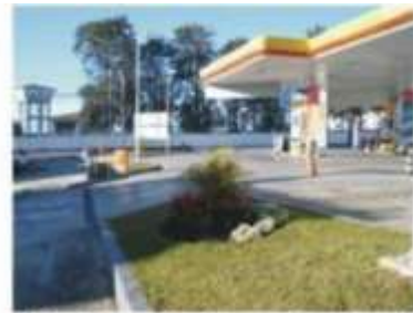
Ajardinamiento en Posto de abastecimiento
