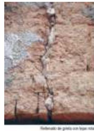
fisura, disminuir la velocidad de secado y reducir la formación de microfisuras en el material de relleno.
