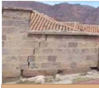
**Grietas y deformación del muro y desgaste del material**
