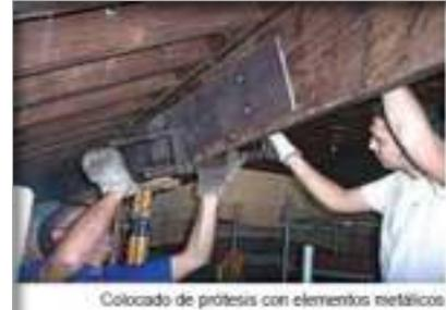
Colocado de prótesis con elementos metálicos
