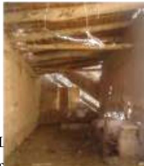
Desprendimiento del revoque, presencia de humedad
