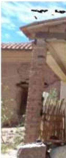
De ladrillo gambote se encuentra en proceso de desgaste por estar en la intemperie sin ningún tipo de cuidado o mantenimient o además que se debe reforzar las juntas para la futura estabilidad de la estructura
