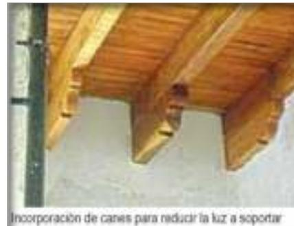
Las piezas de refuerzo pueden ser de madera, metálicas o mixtas.
