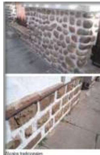
Se debe controlar que las juntas se encuentren sanas y no permitan filtraciones de suciedad y agentes bióticos. Para rellenar las juntas perdidas se debe utilizar **mortero de cal y arena**. Se debe desechar por completo la utilización de morteros de cemento y alquitrán, ya que estos no permiten la respiración de la piedra y por lo tanto del muro de adobe que protege.
