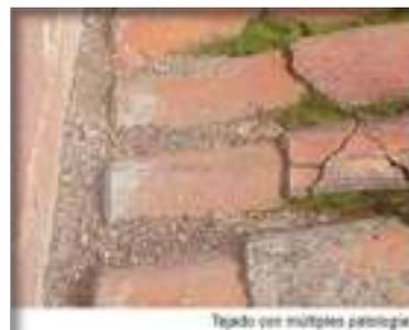
La falla más usual es producto del desplazamiento de las tejas, ocasionando filtraciones que derivan en la pudrición de la armadura de madera.
