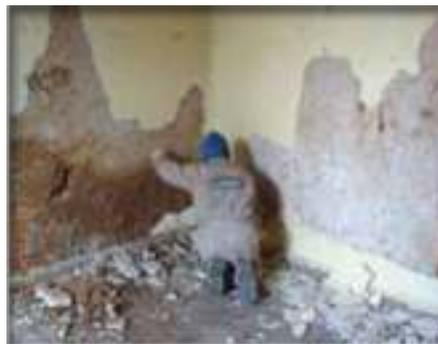
Eliminación de revocos de cemento y partes sueltas
