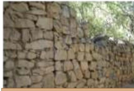
Muro de la bodega desgaste y disgregación
