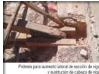
Prótesis para aumento lateral de sección de viga y sustitución de cabeza de viga
