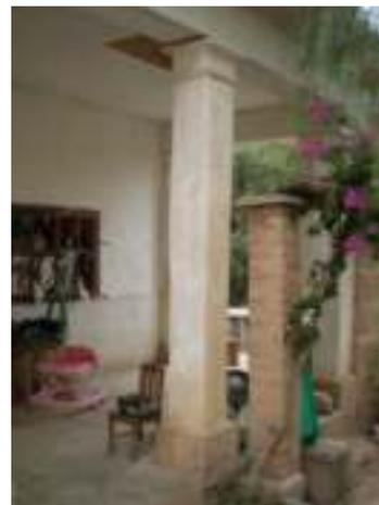
Presencia de agrietamientos, humedad lo que va produciendo el fenómeno de desprendimiento además existe la presencia de grietas por asentamientos
