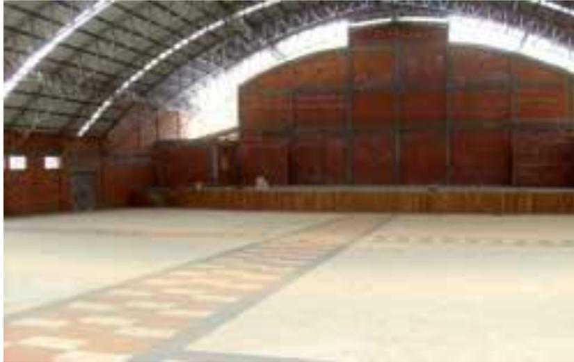
En cuanto a la estructura del campo ferial, está formada por pórticos y estructura metálica, cerchas metálicas que serían los elementos principales de apoyo, los cuales están localizados en las cubiertas de los bloques de exposición.
