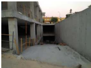
Rampa de bajada a sótano
