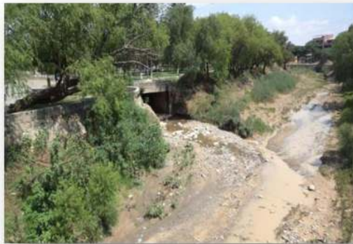
QUEBRADA EL MONTE SOBRE CALLE TORREJON
