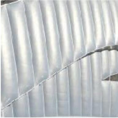
Como vemos, los inflables de ETFE actúan en este caso como sistemas de climatización del edificio, controlando la entrada de luz solar, y con ello, el aislamiento térmico, control de sombras, etc. de forma muy económica energéticamente.
