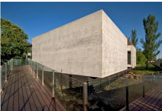
La condición de territorio inundable, situado en un valle fluvial, define la solución planteada desde su inicio. Así, la propuesta queda elevada del terreno natural mediante un sistema de pilotis, realizándose el acceso a través de una rampa que sirve de penetración pero también de elemento que, al elevarse
