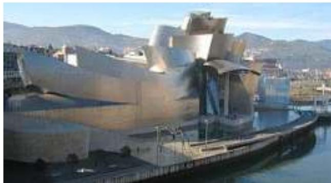
metálica de titanio. Estos volúmenes se combinan con muros cortina de vidrio que dotan de transparencia a todo el edificio. Los muros cortina de cristal han sido tratados especialmente para que la luz natural no dañe las obras, mientras que los paneles metálicos que recubren a modo de "escamas de pez" gran parte de la estructura son láminas de titanio de medio milímetro de espesor, material que presenta unas magníficas condiciones de mantenimiento y preservación. En su
