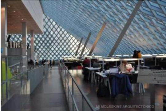
Finalmente, la grilla envolvente en forma de diamante sirve como un elemento de amarre general, a la vez que contiene el recubrimiento de vidrio, el cual tiene una fina capa metálica interior que permite que sea transparente sólo desde el interior
