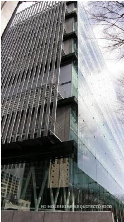
La fachada lateral oeste, que da hacia un lote, es opaca, recubierta con una trama metálica que deja ver las escaleras de emergencia; las fachadas norte y este, que dan hacia sendas calles vecinales, tienen acabados de diferentes por cada piso: vidrio, policarbonato y aluminio.
