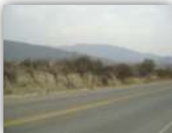
Vía de Acceso, Carretera Bermejo
