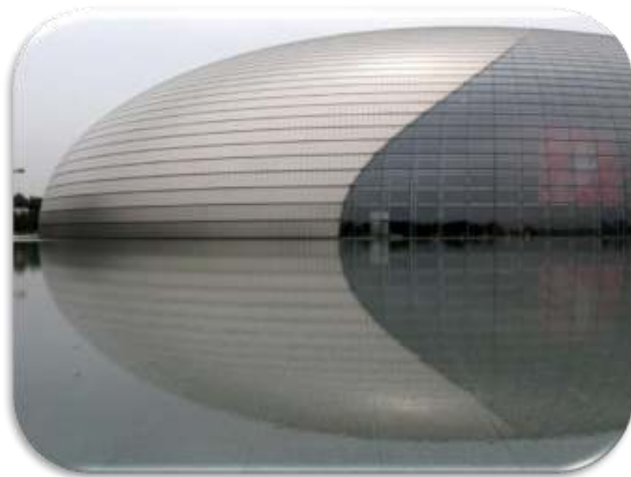
Vista Frontal. Detalle de la Cobertura Envolvente del Centro Nacional de las Artes Escénicas – China.
