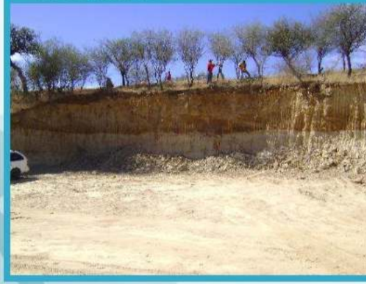
ZONA AMENAZADA POR EROSION Y LOTEAMIENTOS
