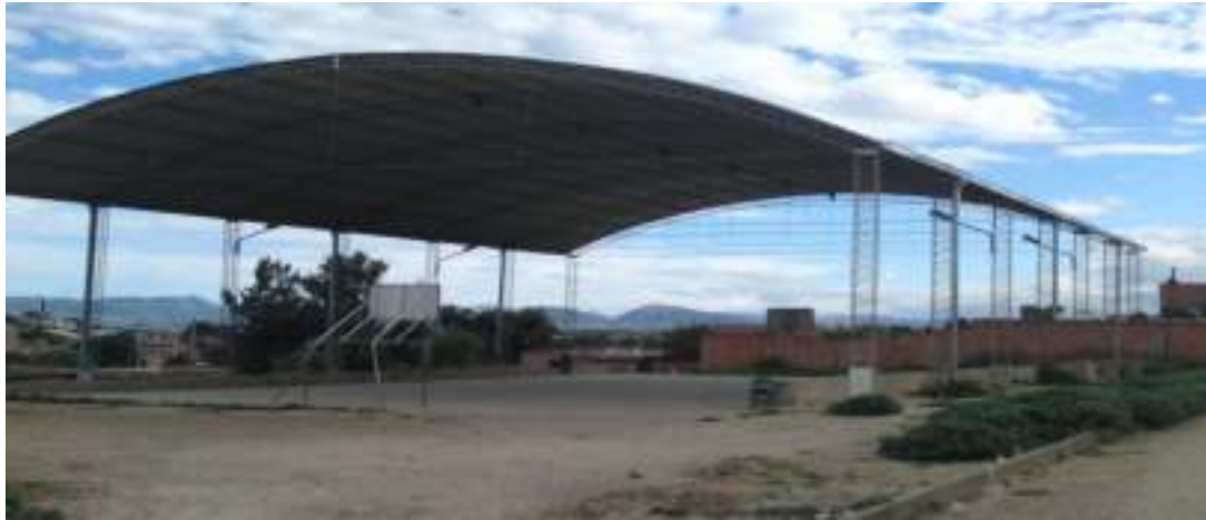
Complejos deportivos vacíos
