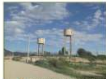
9 Tanques de Agua COBAALT
