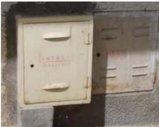
INSTALACION DE GAS A DOMICILIO
