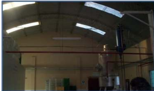
SALA DE PROCESO
