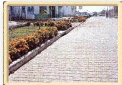
Los pavimentos de losetas de concreto se pueden utilizar en cuanto se terminan, el costo de mantenimiento es bajo y se pueden reparar muy fácilmente.
