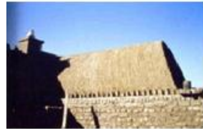
Casa contemporánea en los alrededores de Luxor. Nótese el recargue del adobe sobre el muro izquierdo, más alto que los muros de apoyo de la bóveda. (1984).
