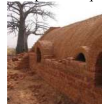
Casa contemporánea en los alrededores de Luxor. Nótese el recargue del adobe sobre el muro izquierdo, más alto que los muros de apoyo de la bóveda. (1984).
